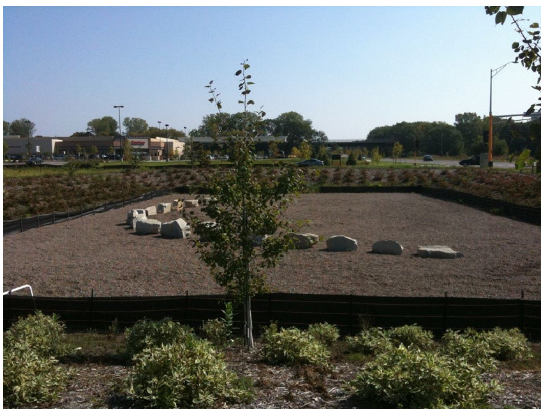
Figur 15. Ett sandfilter med tillsatt järn (5%) under uppbyggnad i St. Paul, Minnesota (USA). Bild av Brian Huser 2007.
