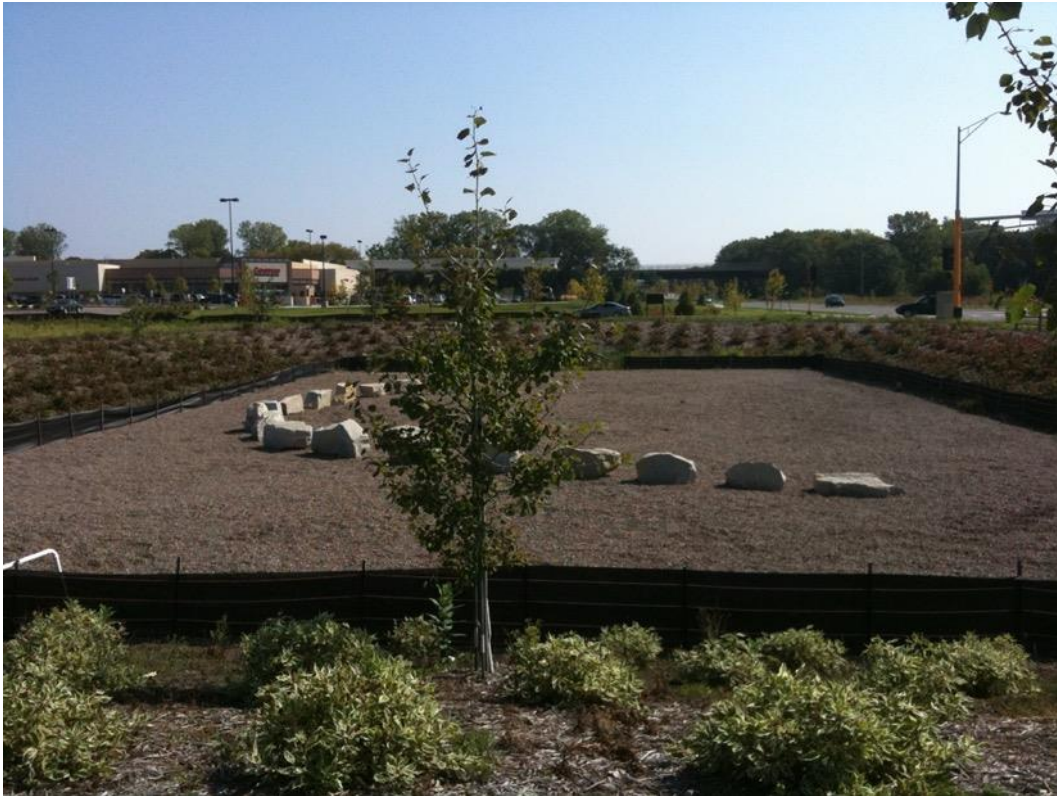
Figur 13. Ett sandfilter med tillsatt järn (5%) under uppbyggnad i St. Paul, Minnesota (USA). Bild av Brian Huser 2007.
