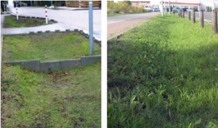
Figur 15. Exempel på hur gräsbeklädda diken kan utformas. Bilderna kommer från Stockholm Vatten och Avfall.
