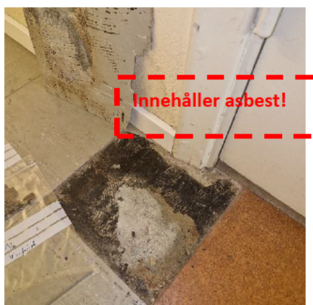
Foto 3 Svartlim under vinylplattor.
