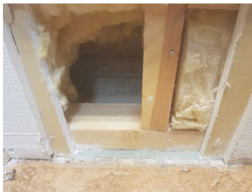
Bild 4 Provplats 15, utreglad vägg
