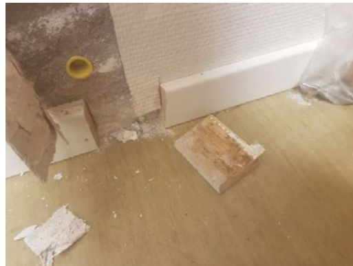
Bild 2 Golvsockeln missfärgad på baksidan
