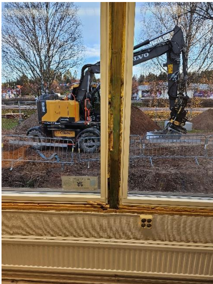
Bild 2 Tryckimpregnerade stående reglar innehållande klorfenol, kloranisol och PCB (provplats 6)
