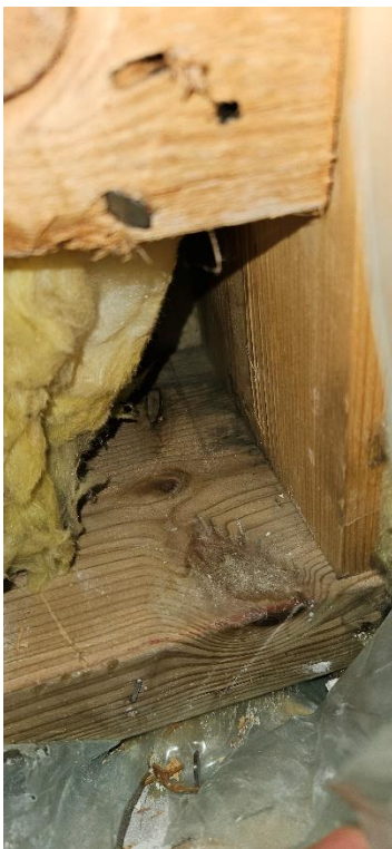
Bild 9 Tryckimpregnerad och mikrobiellt skadad syll (provplats 25)
