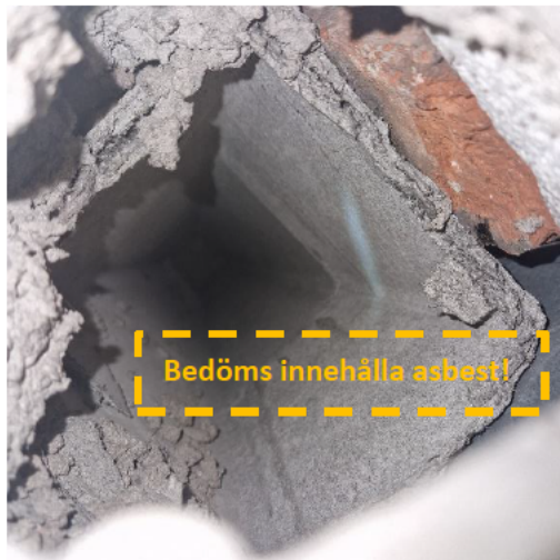
Foto 11 Eternitkanal i källaren hus B.
