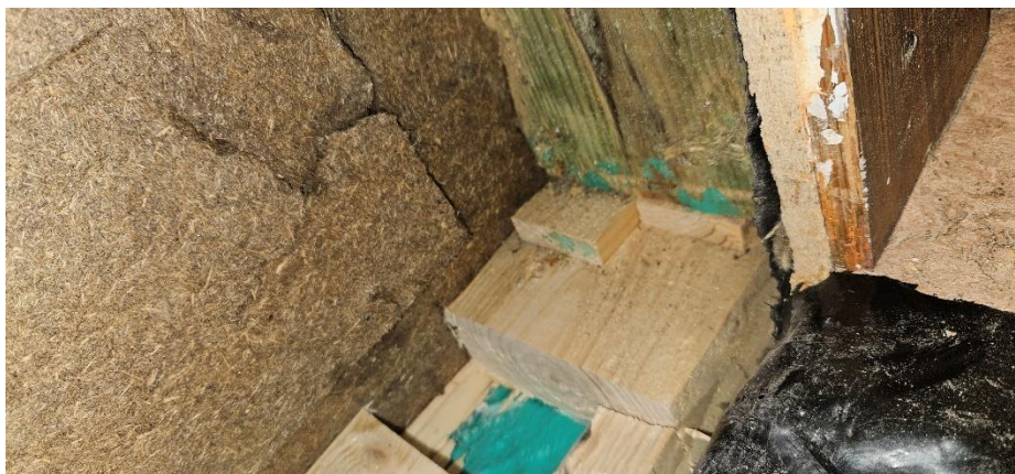
Bild 6 Stående regler innehållande klorfenol och kloranisoler (provplats 12)
