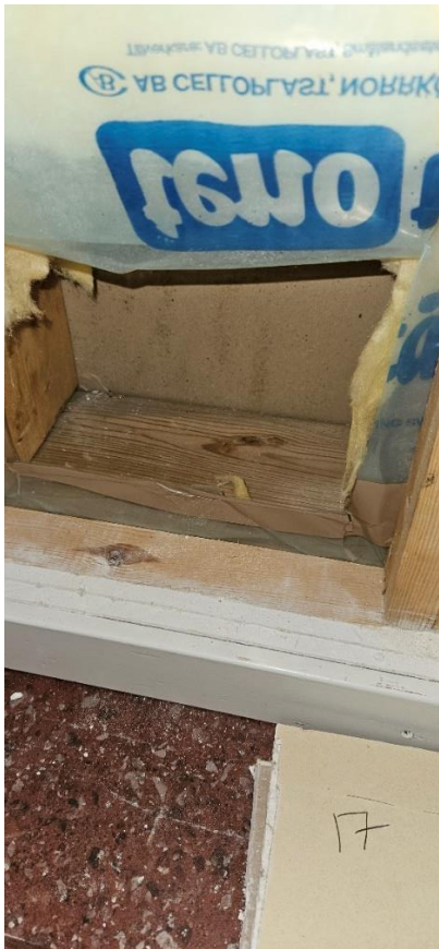
Bild 8. Tryckimpregnerad syll innehållande klorfenol (provplats 17)
