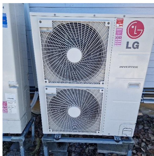
Foto 15 Luftvärmepumpar.
