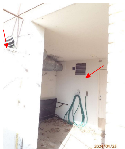
Bild 6 Avluftsutblås och inluftsintag till fläktaggregat i blått område, bild 4.
