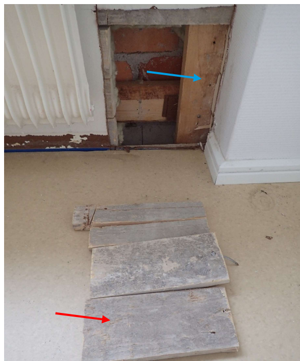
Bild 16 Provtagningsplats rum 154. Blå pil visar synbara rinnmärken på regel ovan provtagen kil i regelns nederkant mot betongen. Röd pil visar synbart bruksvattenpåverkad råspont.
